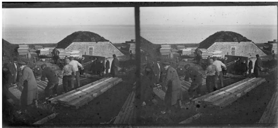
Construction du camp, hommes tirant un bloc de béton (Plaque de verre 130 x 60 mm, négatif, binoculaire, bon état)
