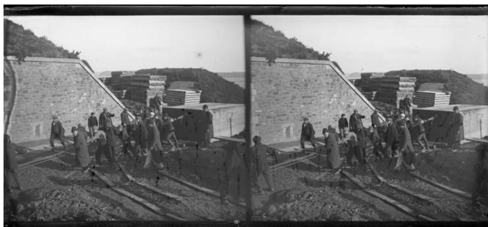
Construction du camp, hommes tirant un bloc de béton (Plaque de verre 130 x 60 mm, négatif, binoculaire, bon état)
